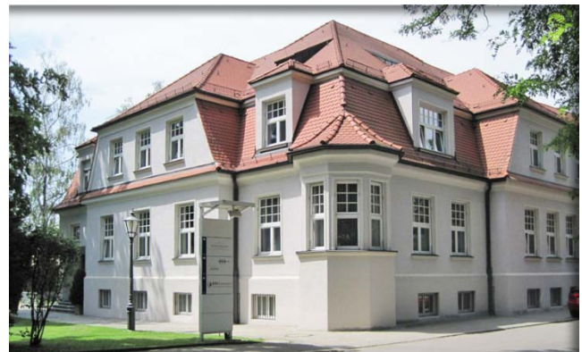
Villa 1 (Gebäude A3)
